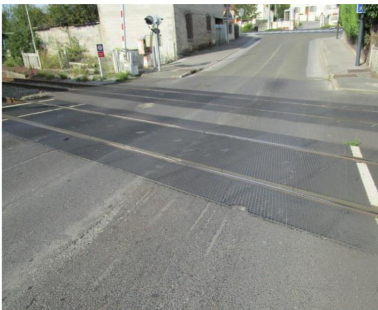
Des traces d'accroches sont visibles sur la chaussée, signe d'un profil de franchissement difficile avéré pour certaines catégories de véhicules.
